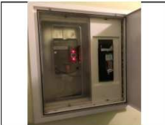
Quadro eléctrico comum
